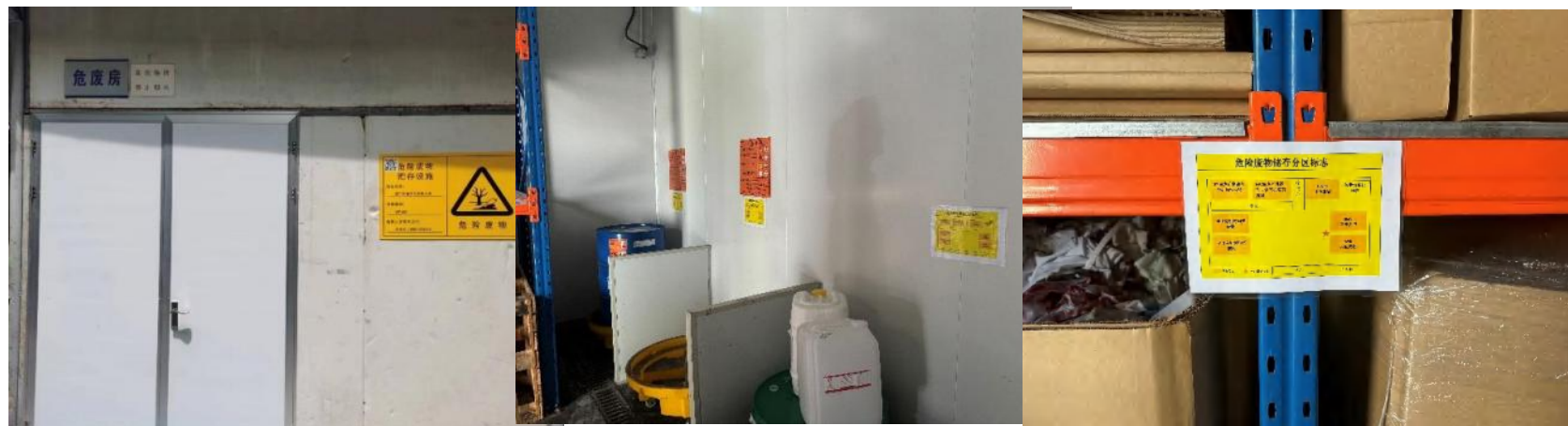
危险废弃物仓库
